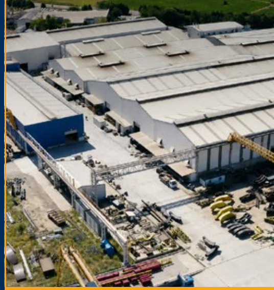
TİS Deprem Teknolojileri Fabrikası
