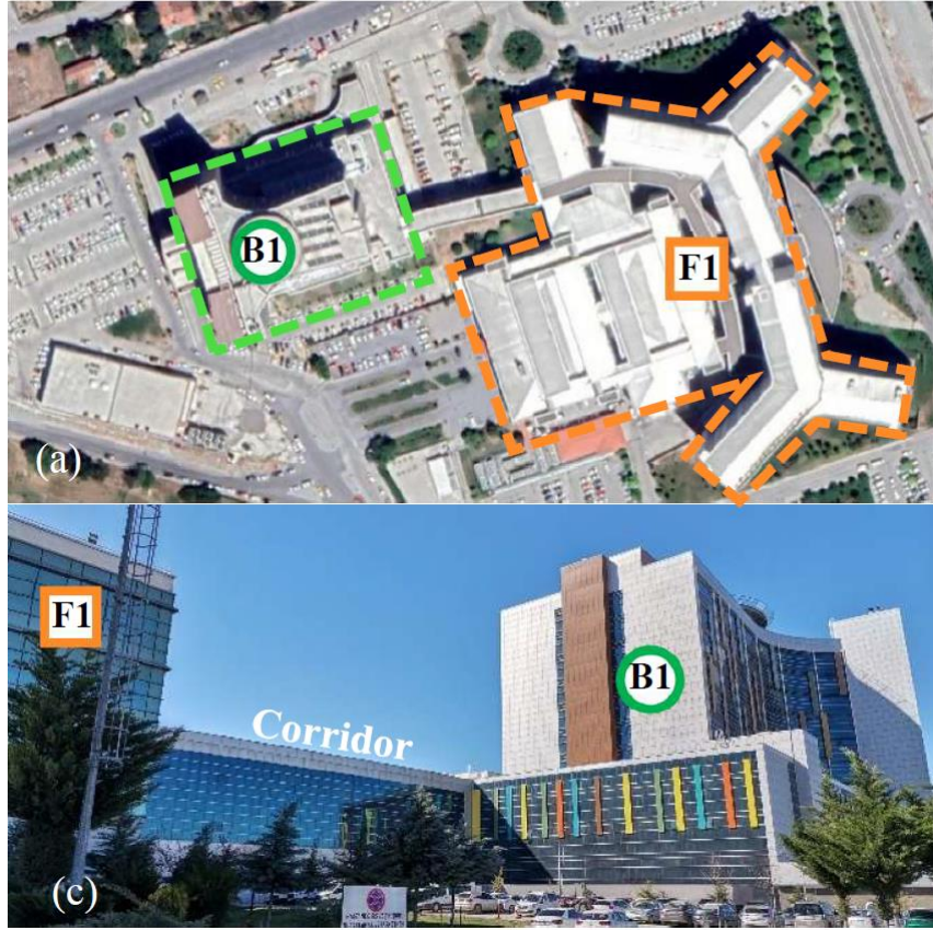
Şekil 7: TDP deprem izolatörlü Malatya Eğitim Kadın Doğum ve Çocuk Hastanesi binası (görsellerde B1 ile gösterilmiştir) ve deprem izolatörsüz olarak 2010 yılında inşa edilen Malatya Eğitim ve Araştırma Hastanesi binalarının (görsellerde F1 ile gösterilmiştir) konumları
